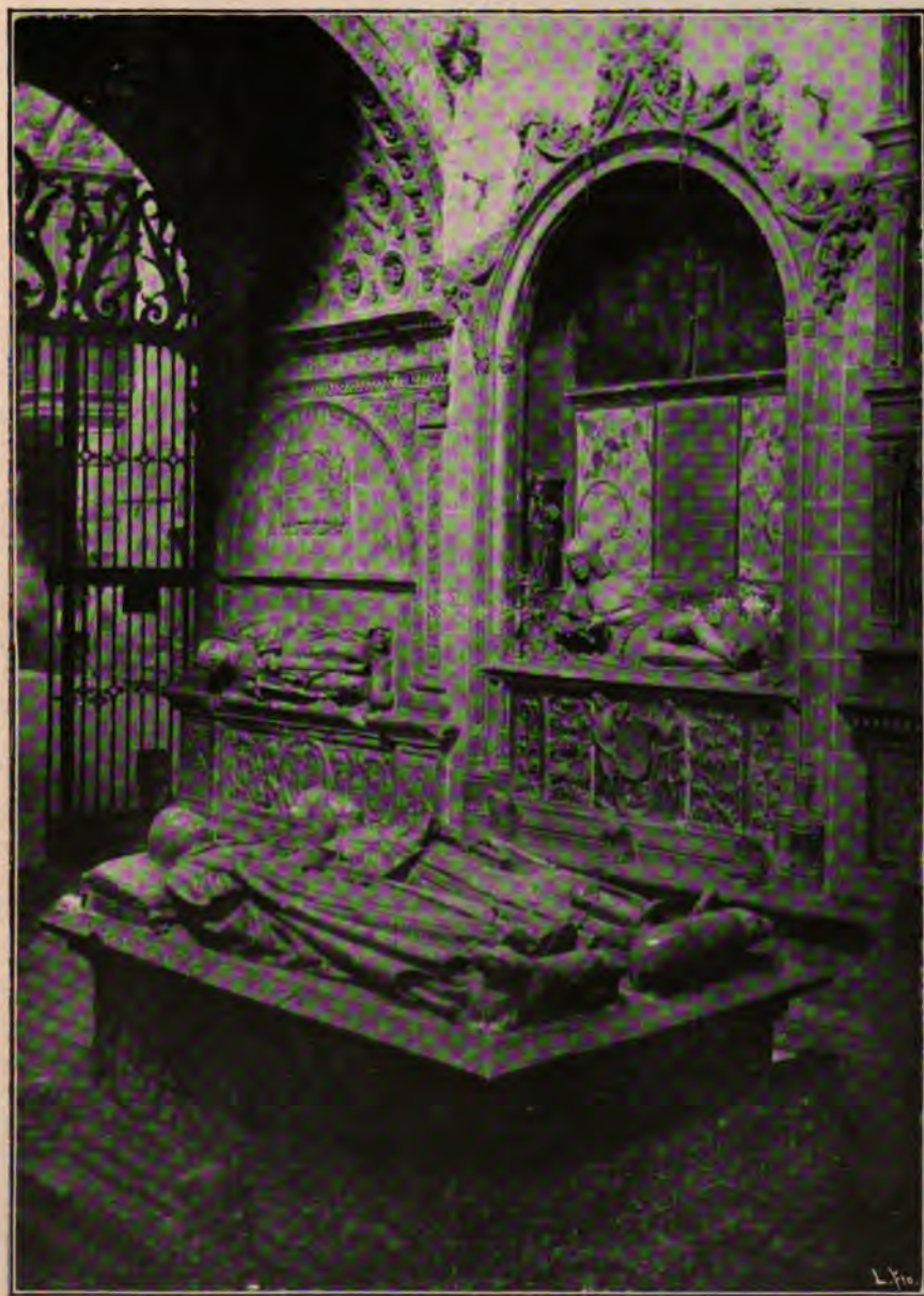
CAPILLA DE SAN JUAN Y SANTA CATALINA CON LOS ENTERRAMIENTOS DE LOS ARCES.—(FOT. DE D. F. MAMBLONA)
